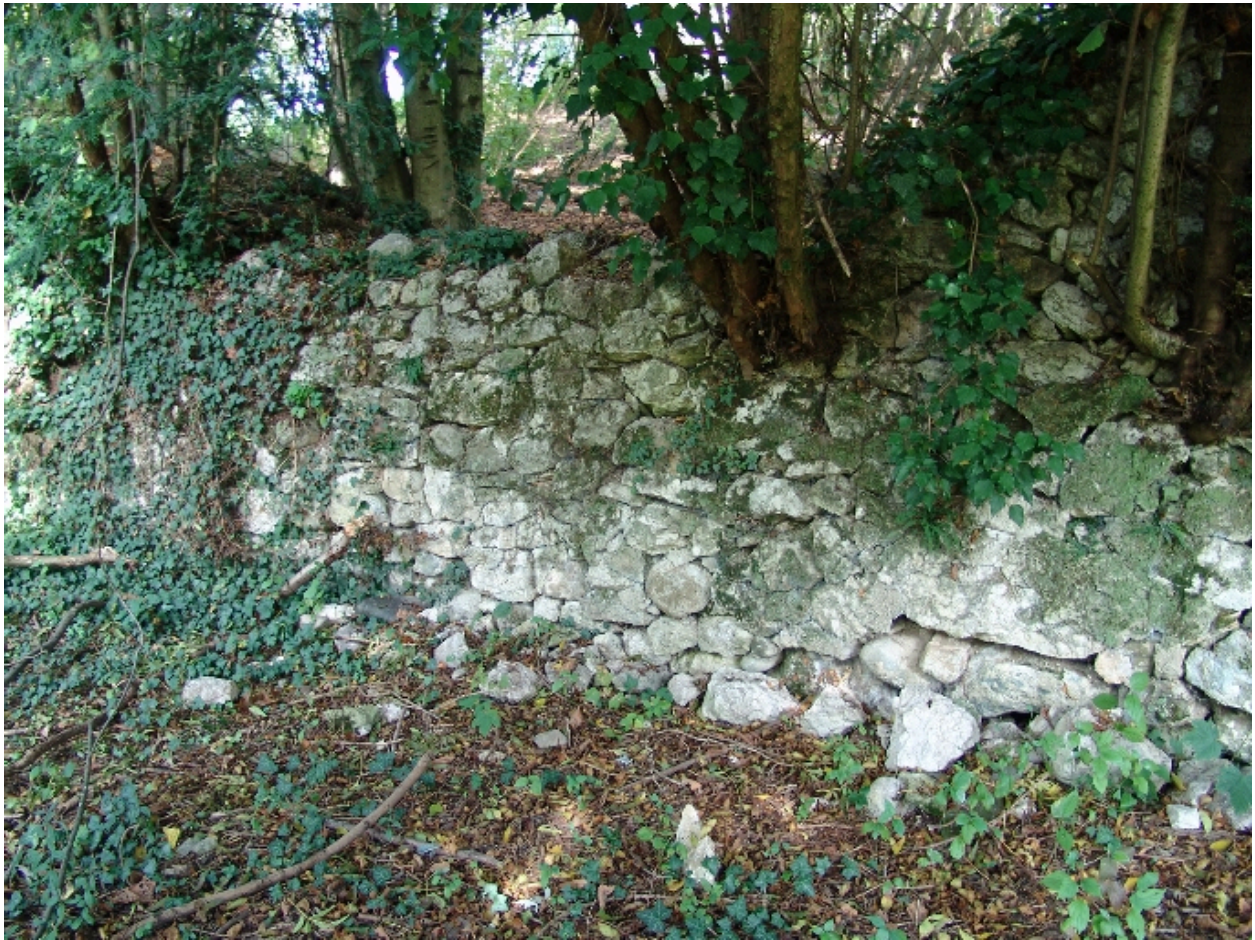
mur de soutènement
