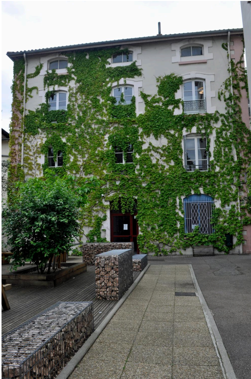
Bâtiment sur cour, élévation antérieure
