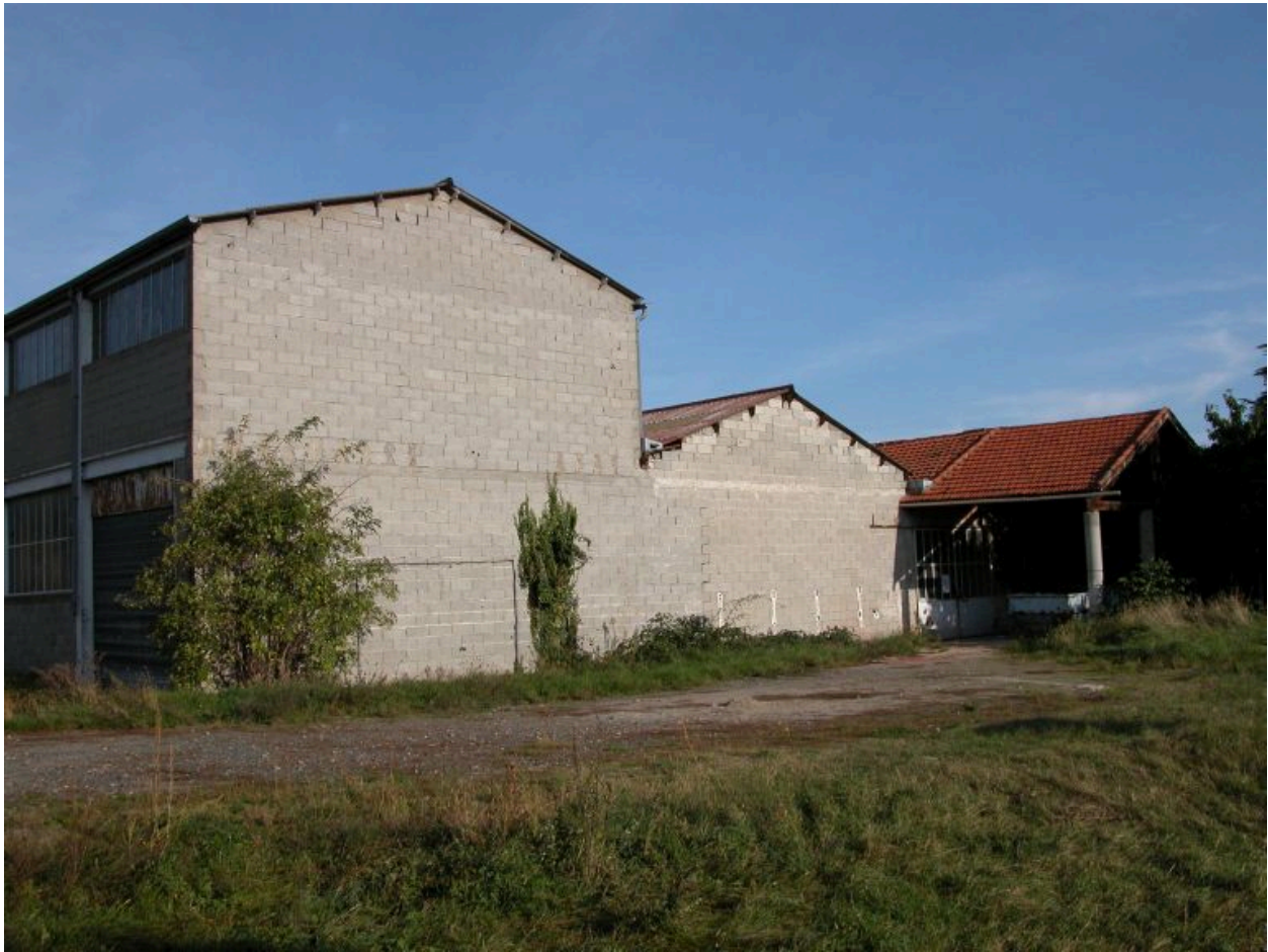
Reclava (la), Usines abandonnée AI 205, 206. Vue d'ensemble des ateliers.
