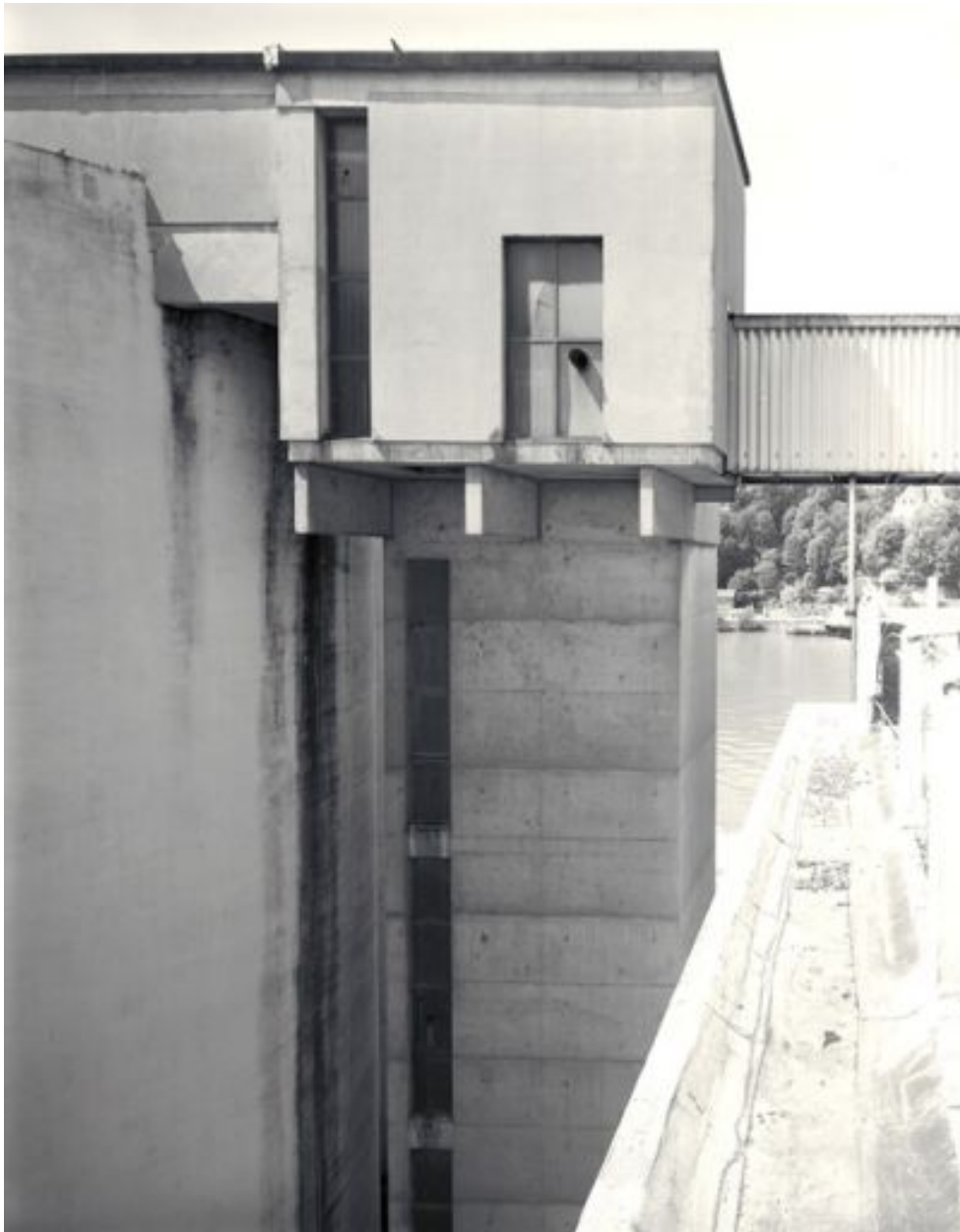
La cage des ascenseurs depuis le toit terrasse
