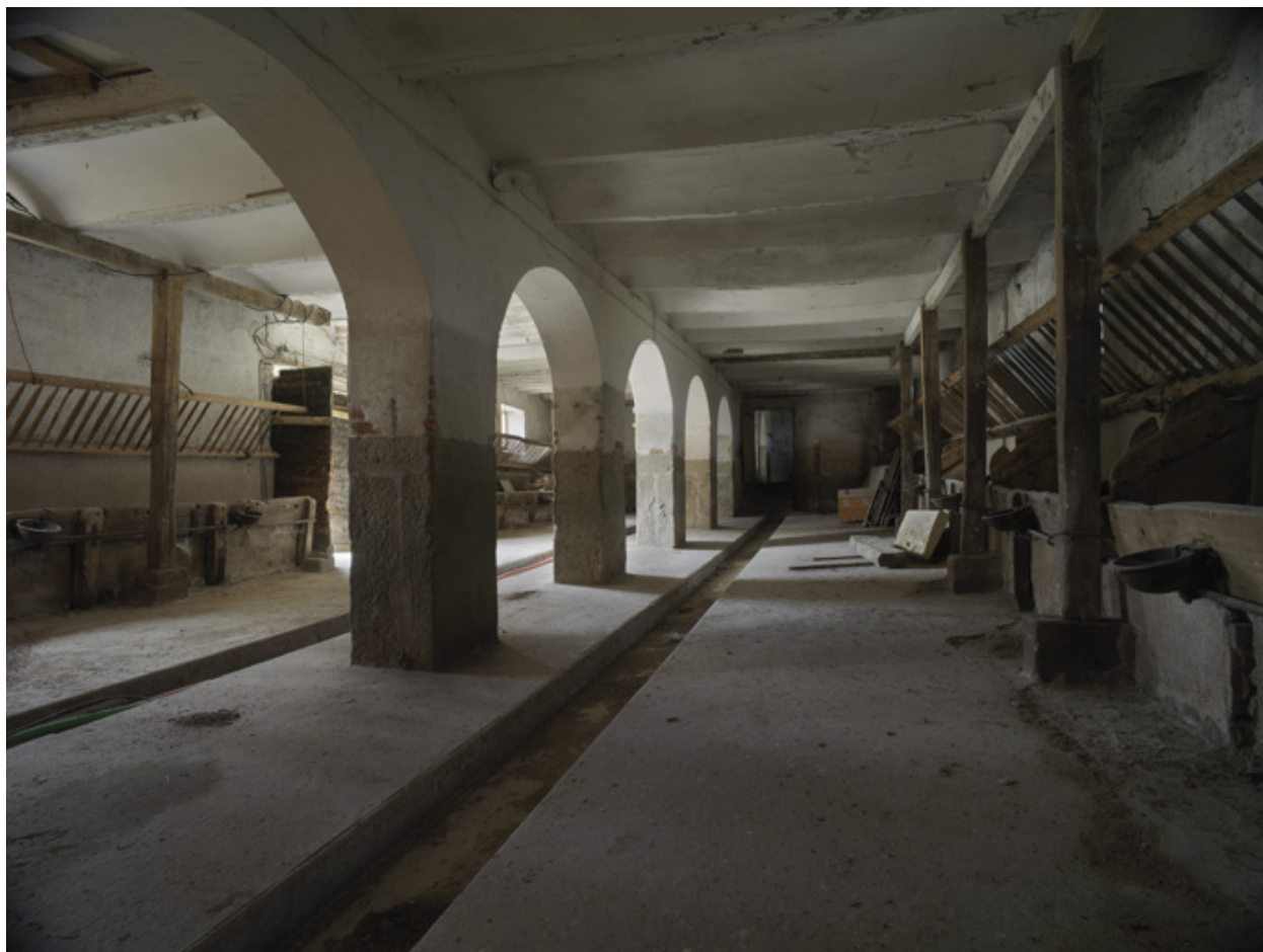
Vue intérieure de l'étable (partie est), depuis l'est.
