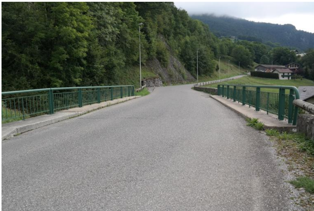
Pont de Fontanil, vue de la chaussée et des garde-corps
