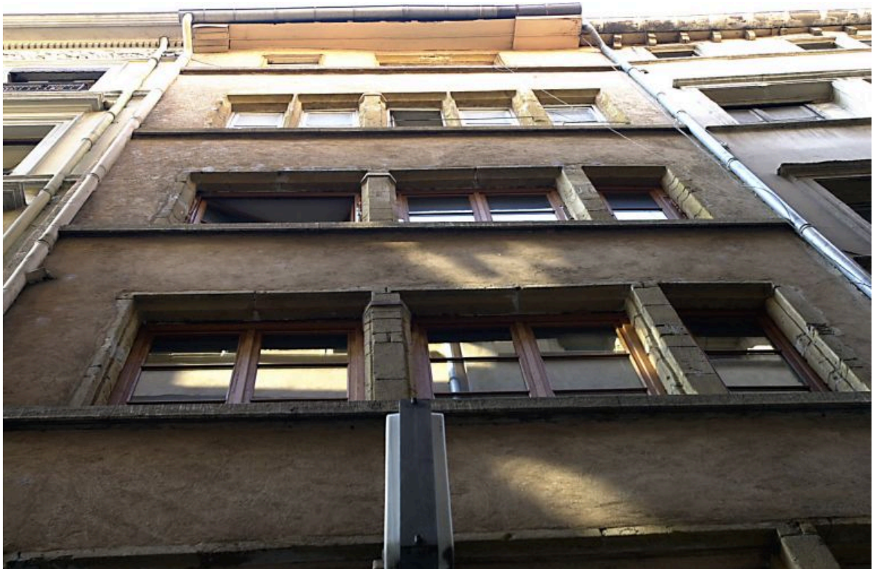
Façade sur rue, vue des 4 étages supérieurs
