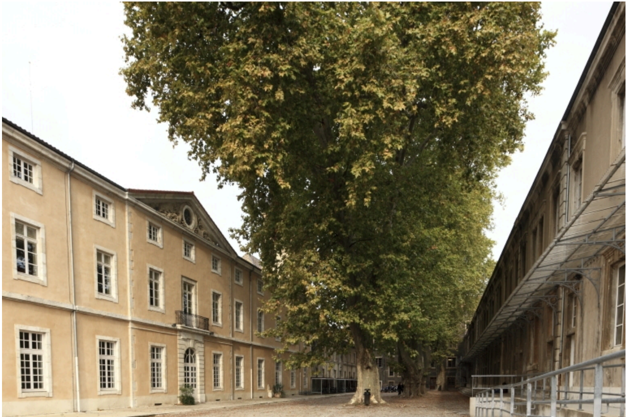
Bâtiment C. Cour intérieure sud. Façade orientale, 18e siècle à gauche, du bâtiment B, 19e siècle à droite.
