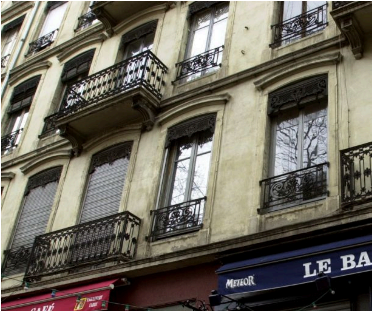
Détail des fenêtres, 25 cours Suchet
