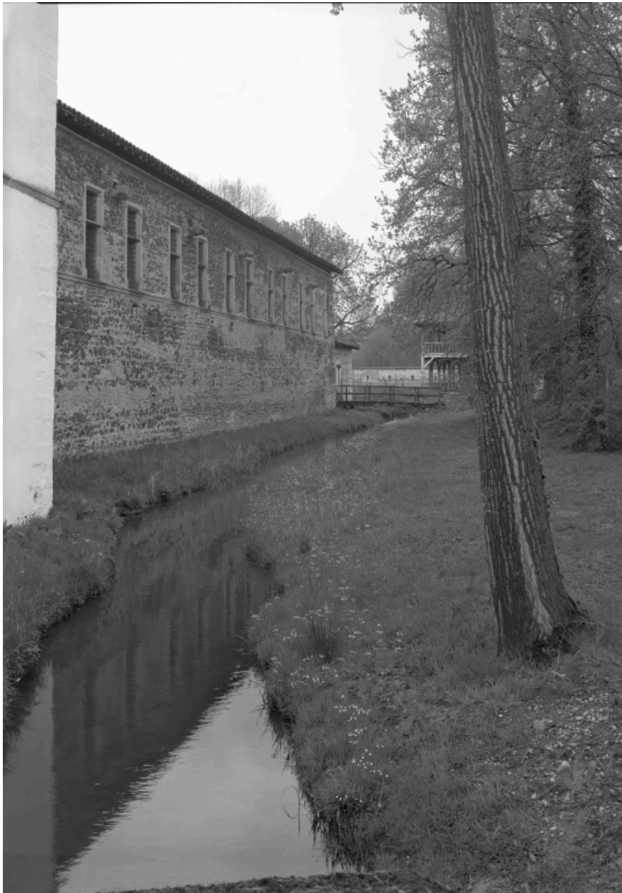
Vue des douves devant la façade est du corps dit de garde, du sud-est.
