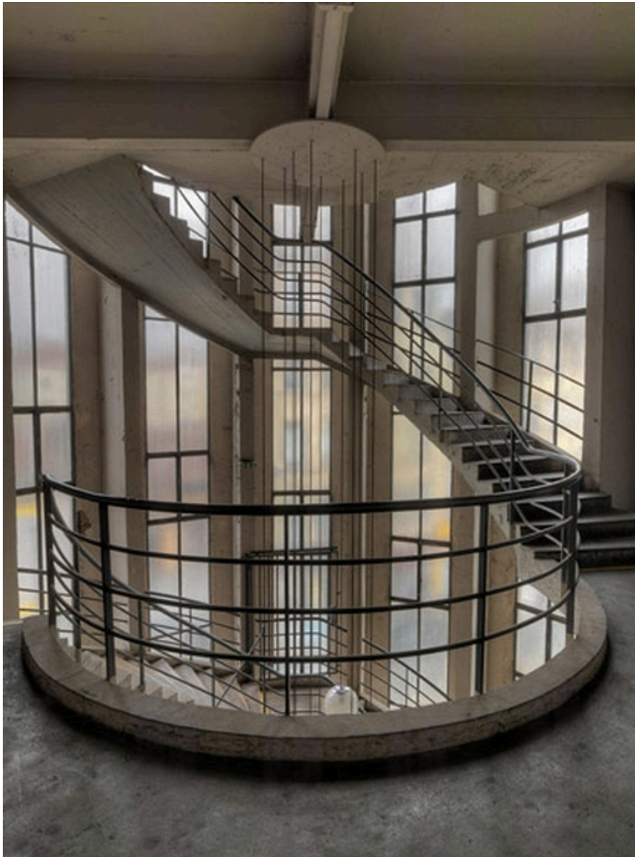
Escalier tour nord-ouest
