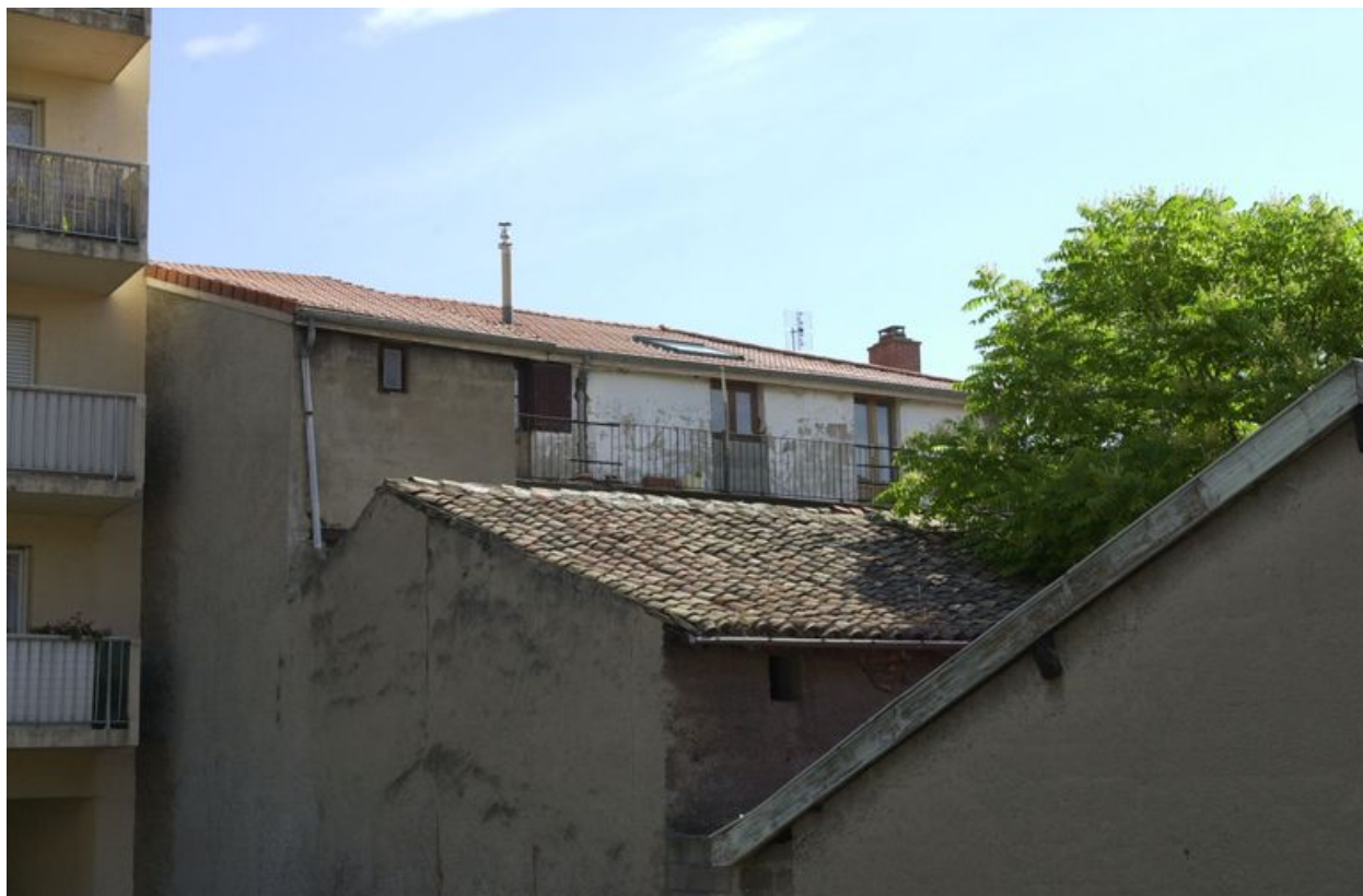
Vue de la façade arrière des maisons
