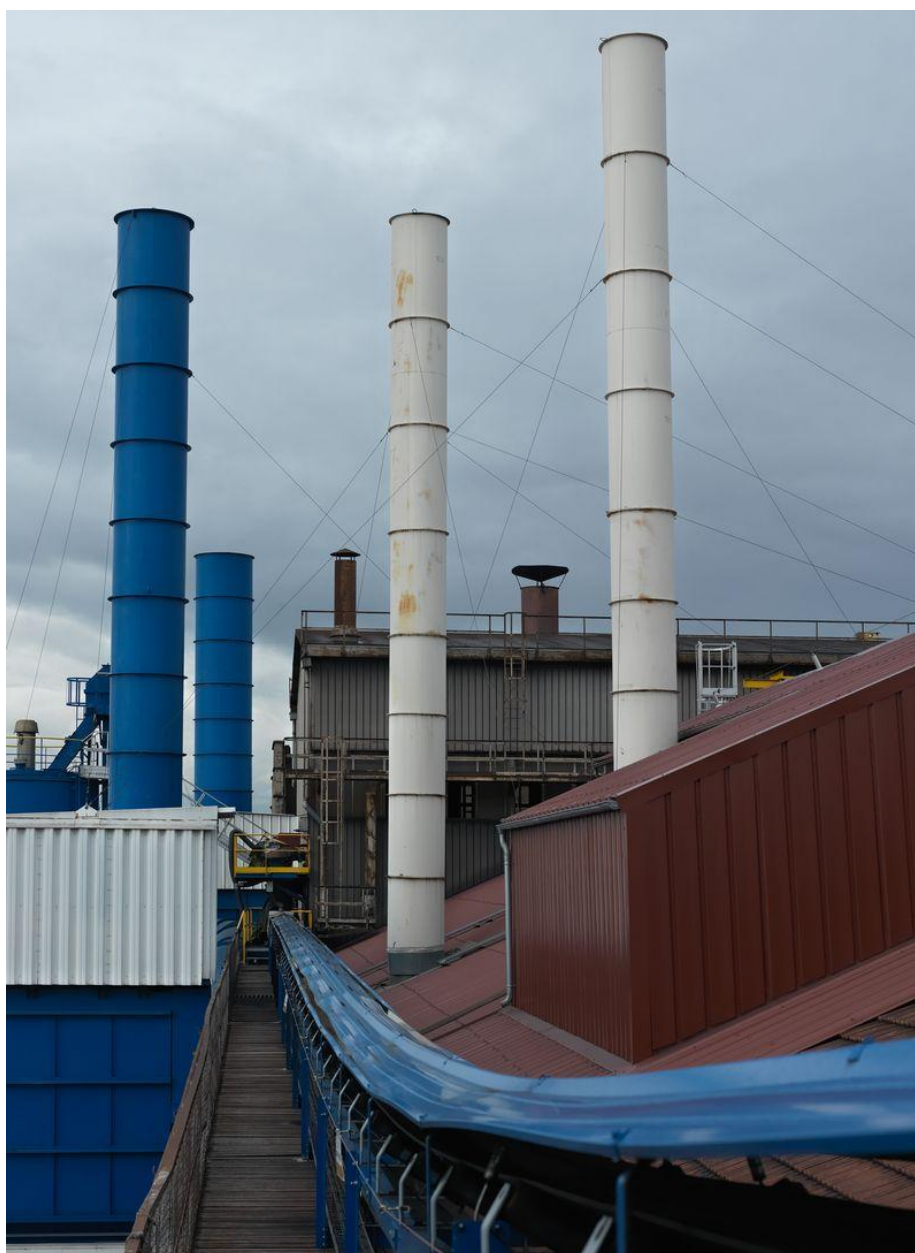
Vue des cheminées métalliques
