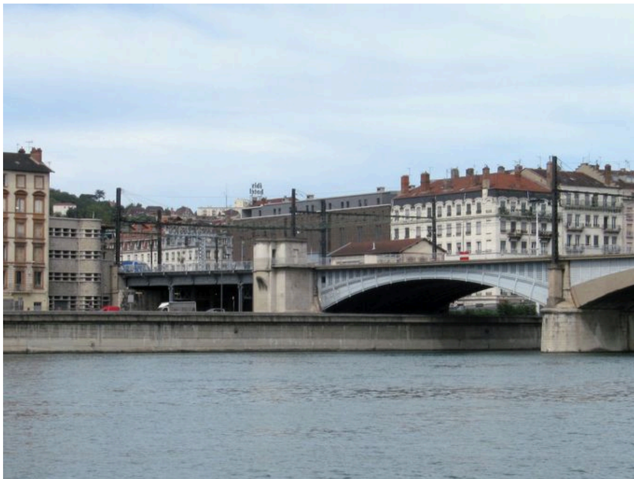
Vue partielle, travée de rive et travée droite, face aval (depuis la rive gauche)
