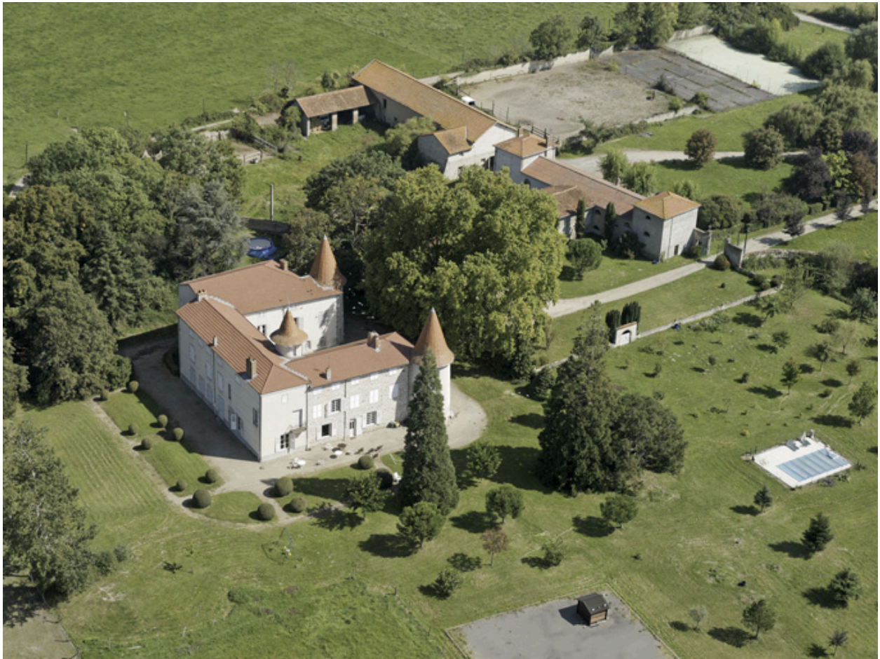
Vue générale aérienne du château et des communs, depuis le sud-ouest.
