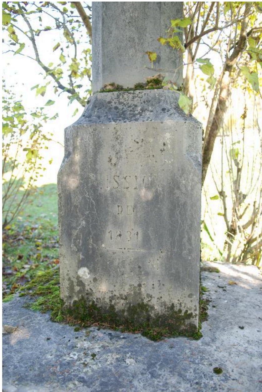
Détail de la base de la croix.
