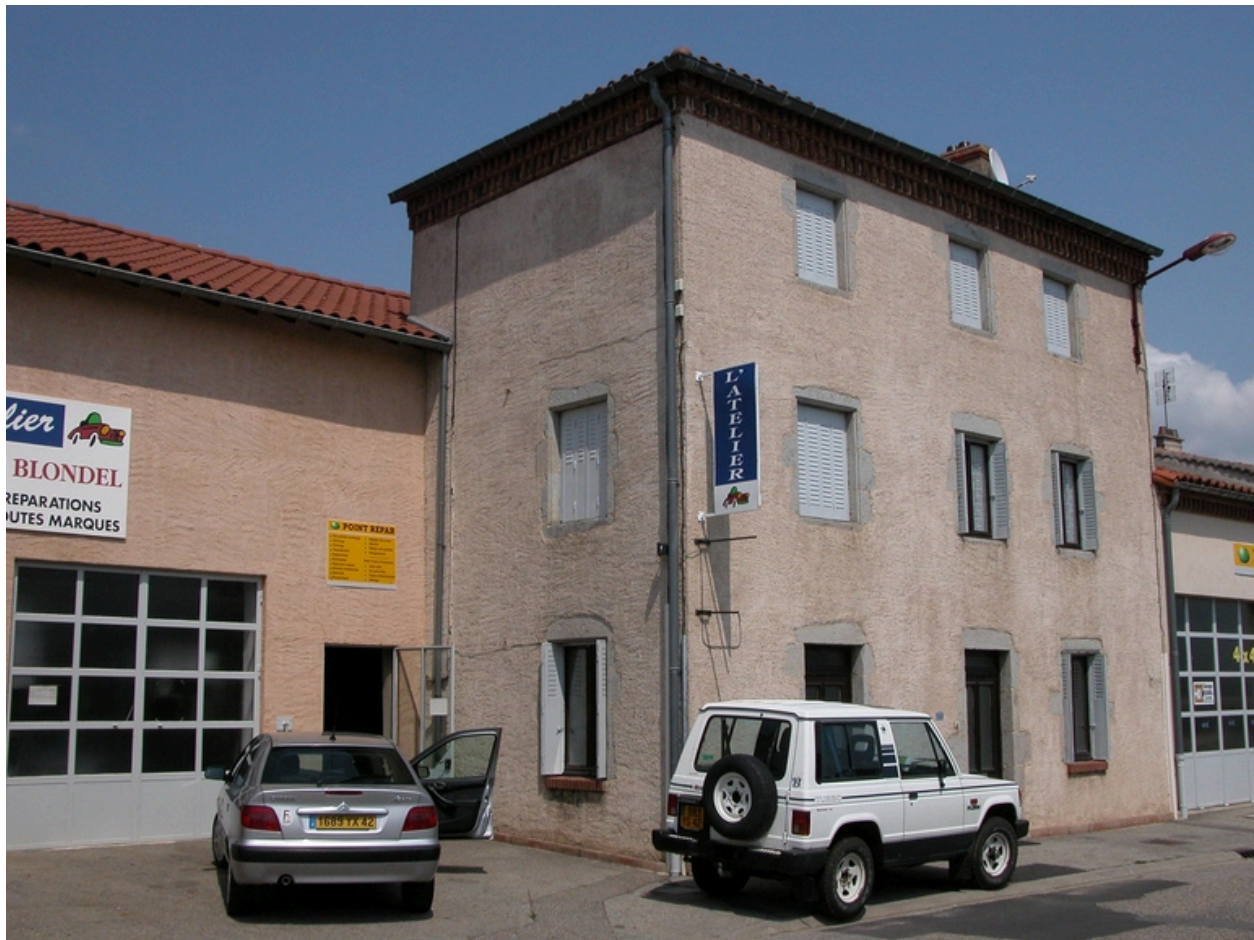
Faubourg des Gayottes, rue des Gayottes. Garage (1999 AD 65).
