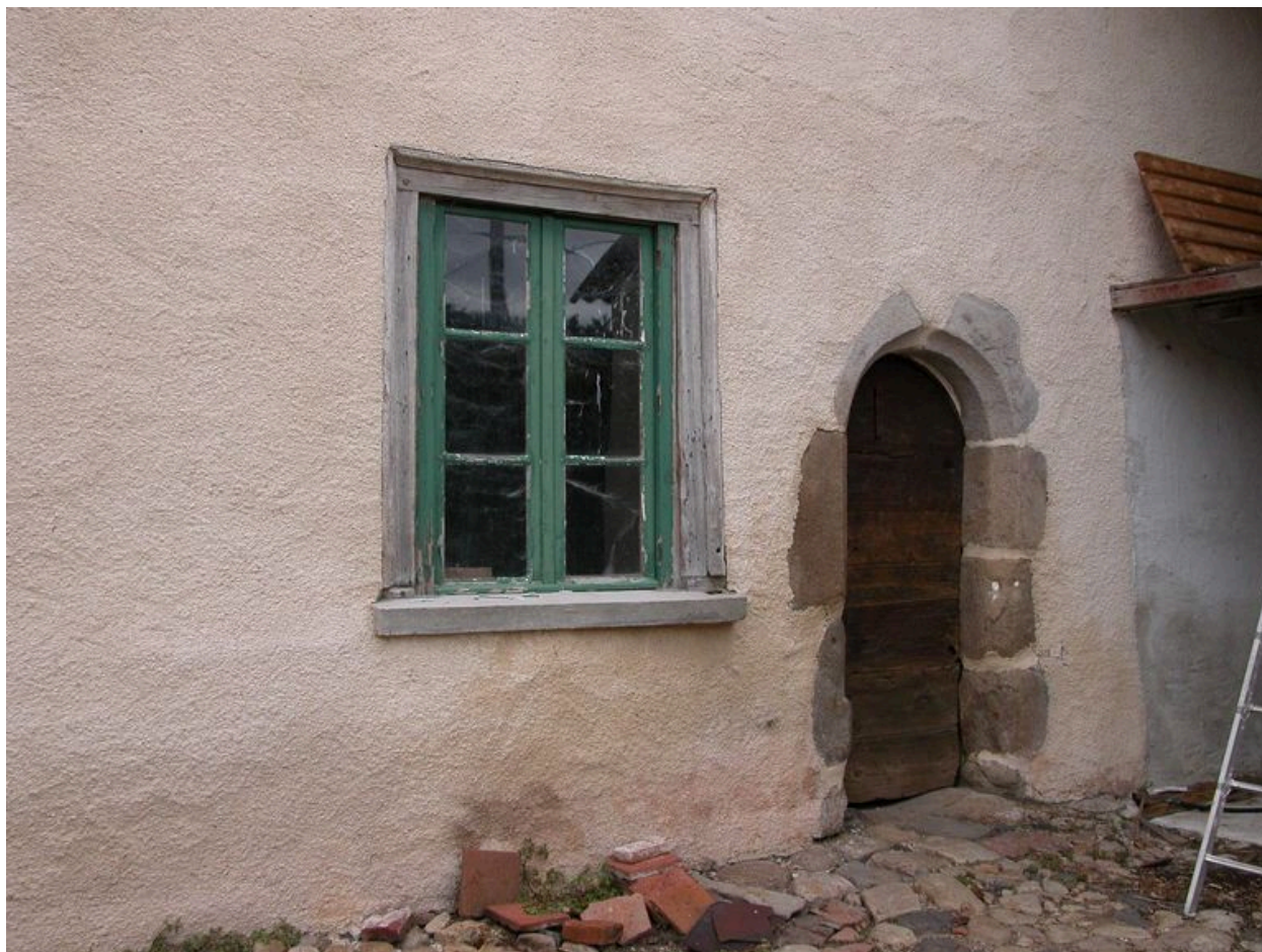
Vue de la façade du logis.
