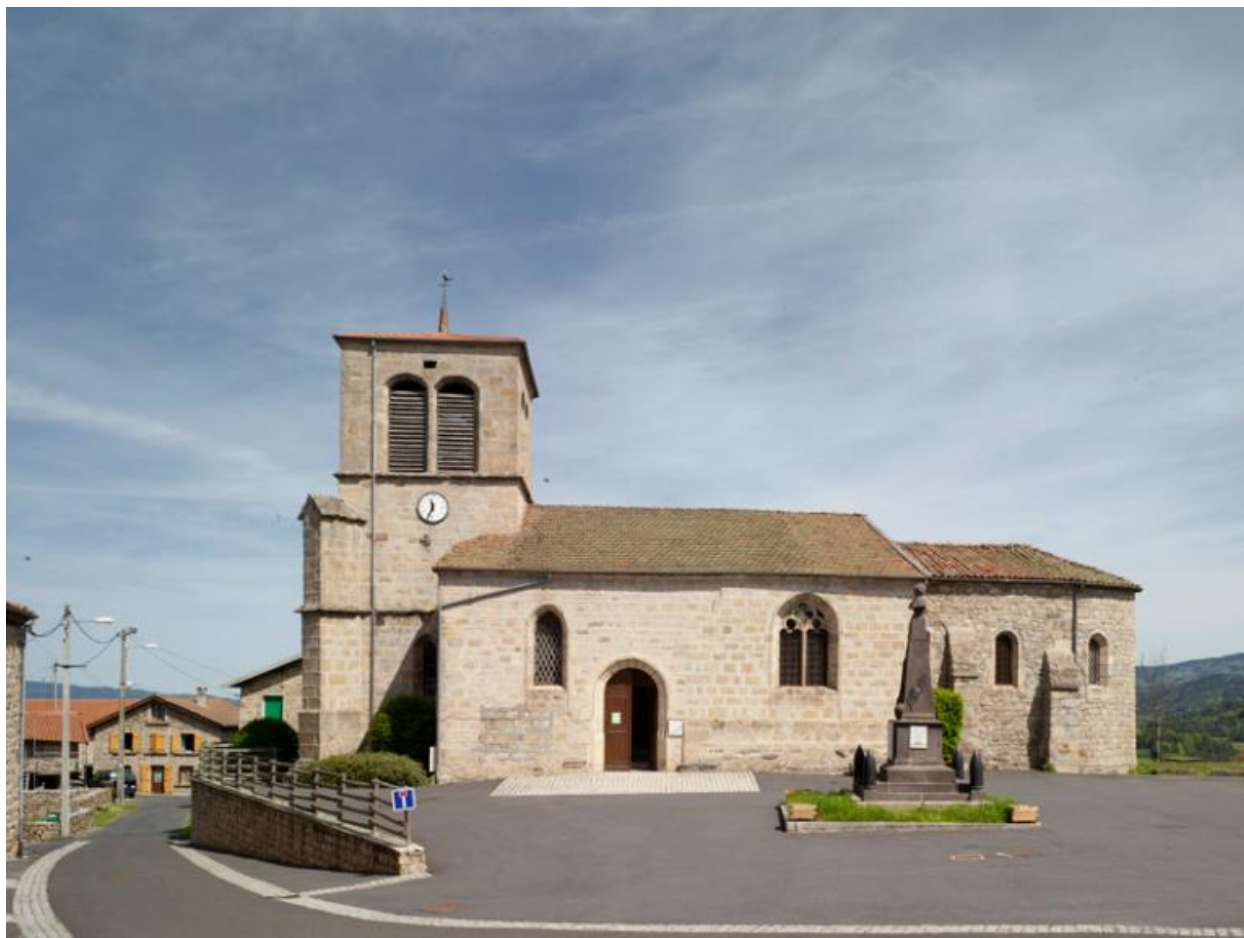
Vue générale de la façade méridionale.
