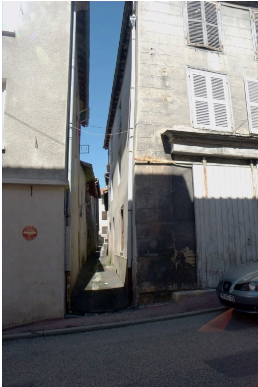
Îlot 2. Saint-Jean (rue) 28, 30. Vue générale de la traversière entre les deux maisons.
