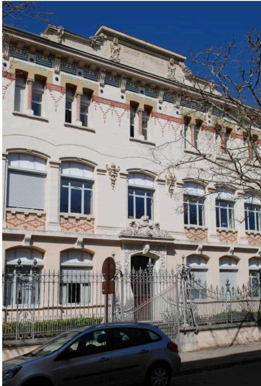
Elévation principale, partie centrale
