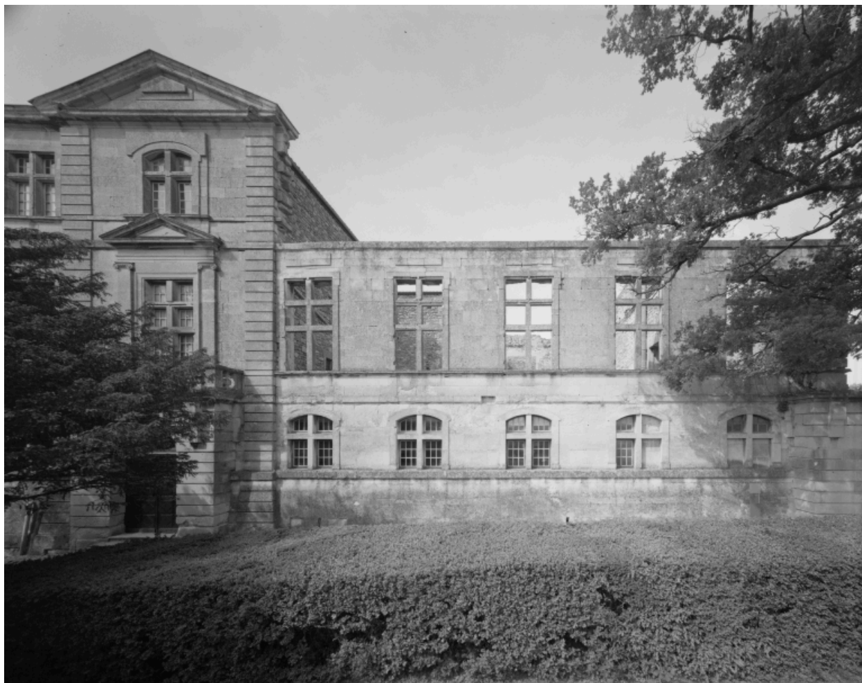
Aile dite des prélats. Façade est. Corps central et partie nord.
