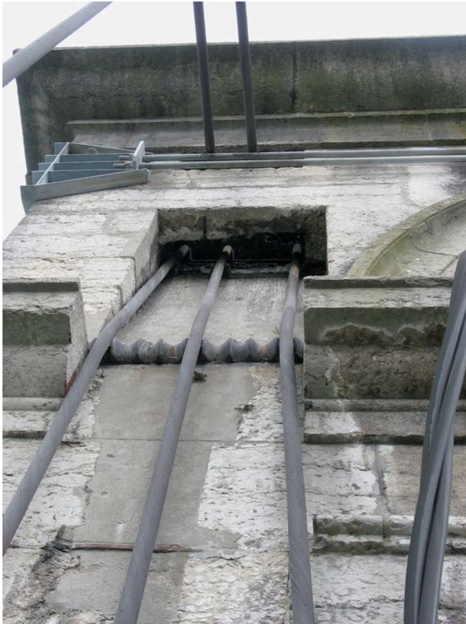
Pile, vue de détail : ancrage d'un des câbles porteurs (depuis la rive droite)
