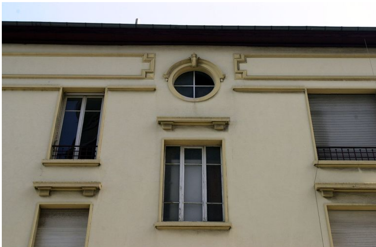
Immeuble, façade sur la rue Jaboulay, détail
