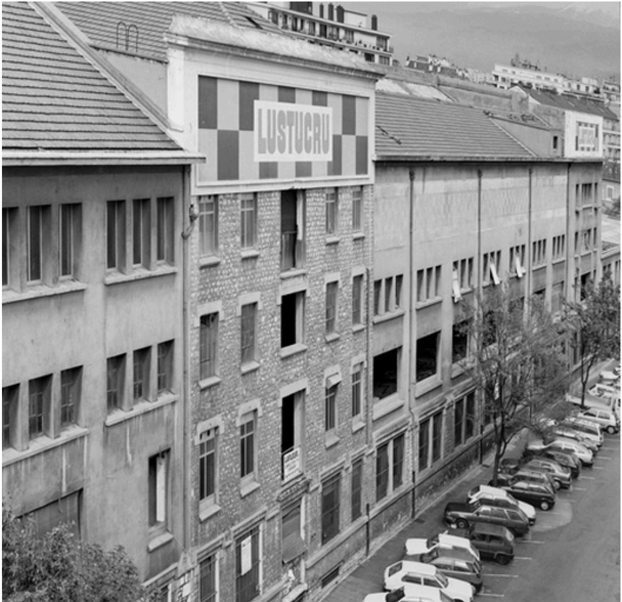
Vue générale (auteur de la photographie : Didier Gourbin)
