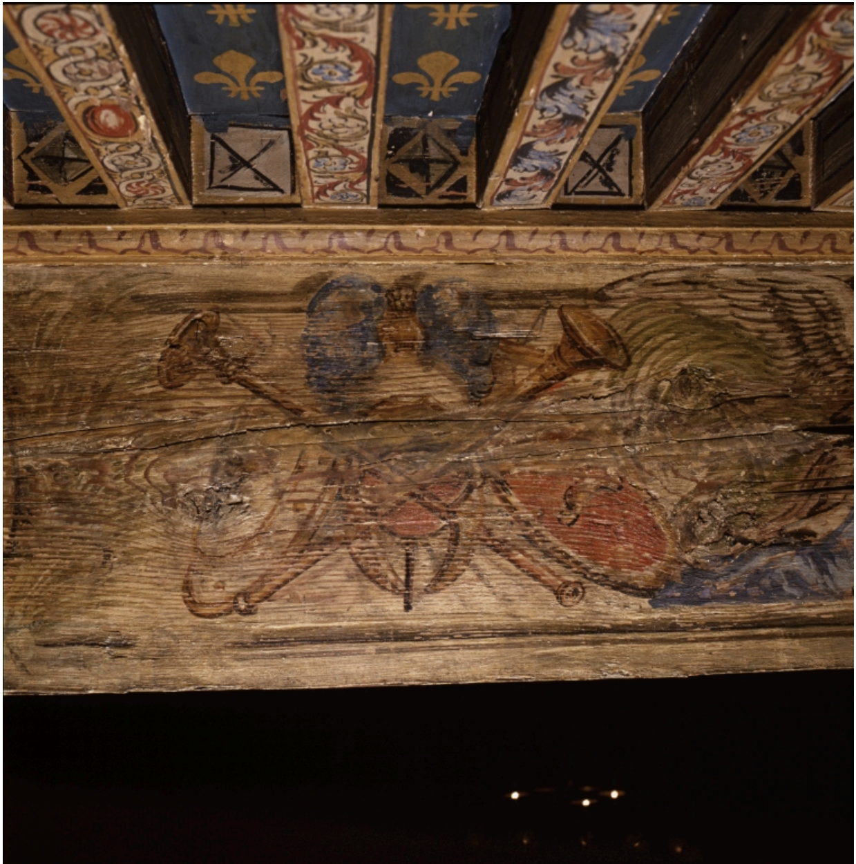
Poutre 5, face sud, centre gauche.
