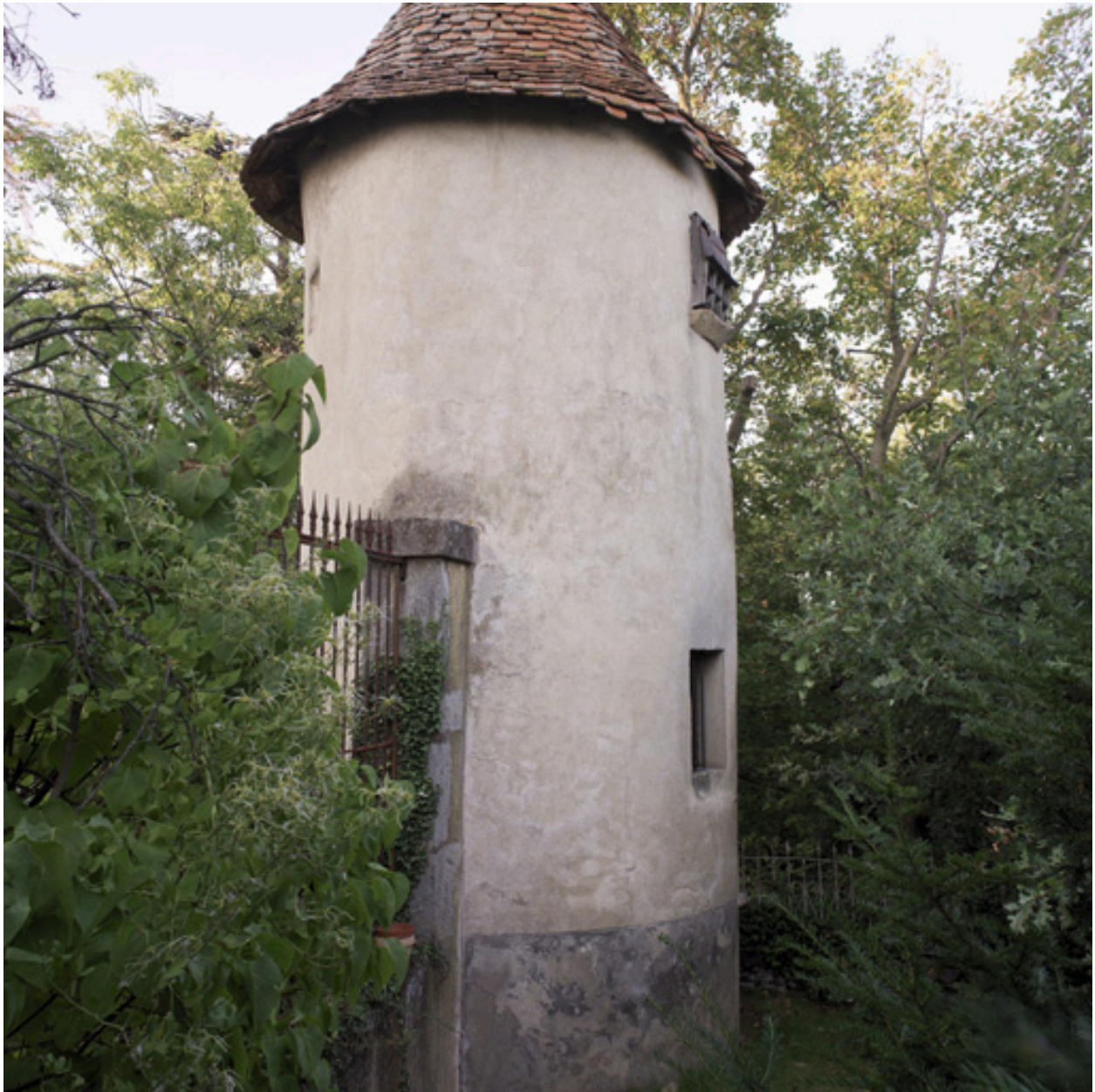
Vue de la tourelle d'angle de la cour orientale, depuis la terrasse sud.
