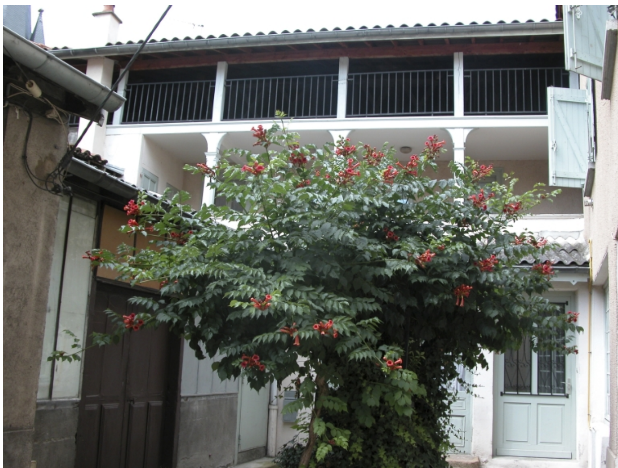
Îlot 9. Carnot (place) 24, 26. Vue partielle de la façade arrière sur la cour.
