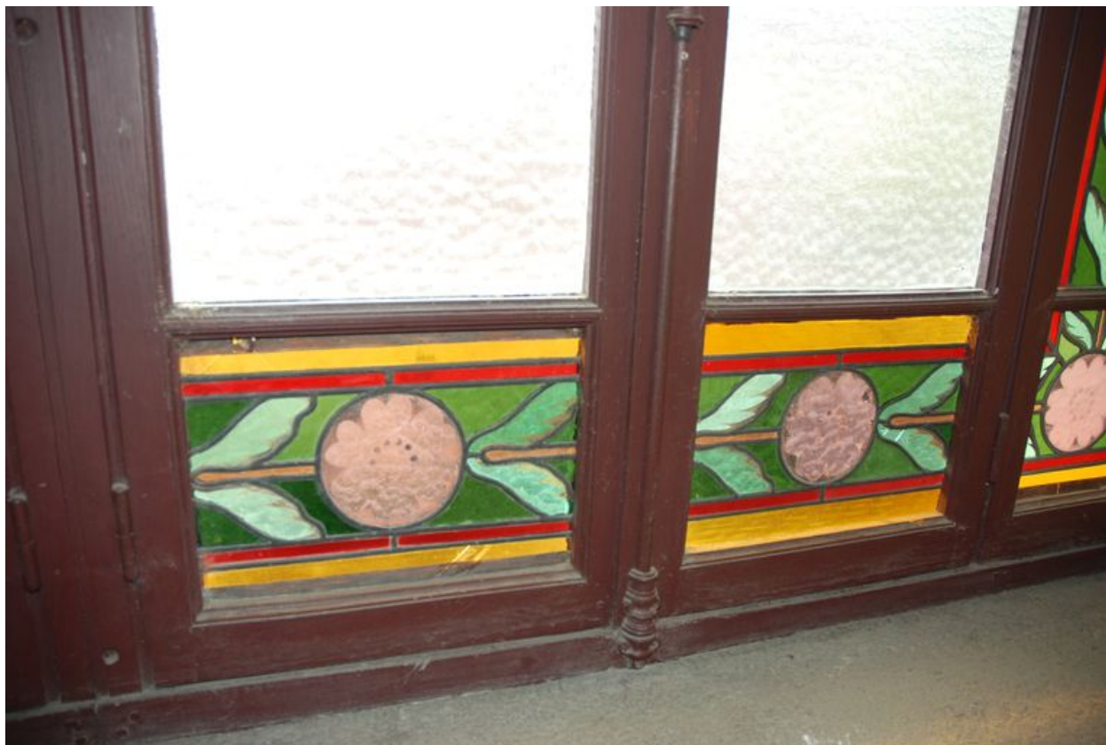
Détail d'une verrière dans la cage d'escalier
