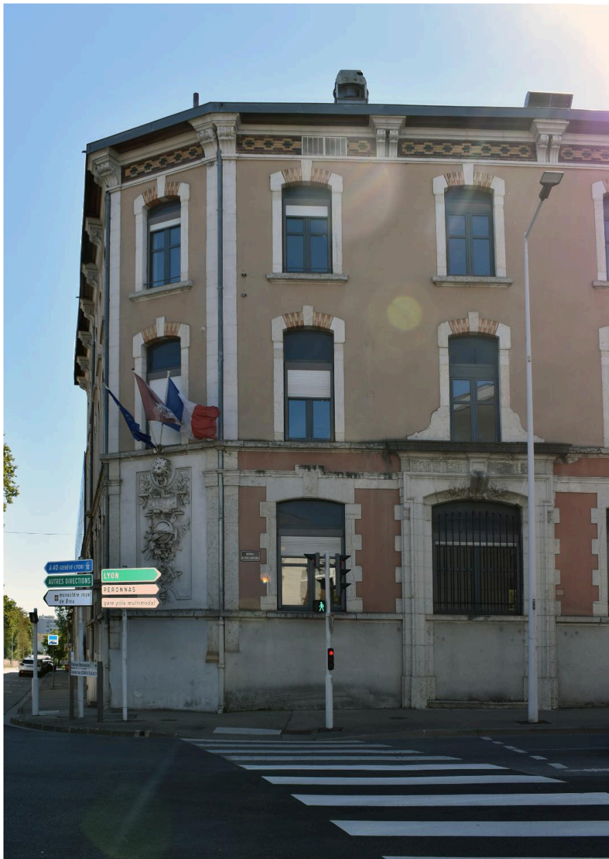
Elévation principale : détail de l'angle nord
