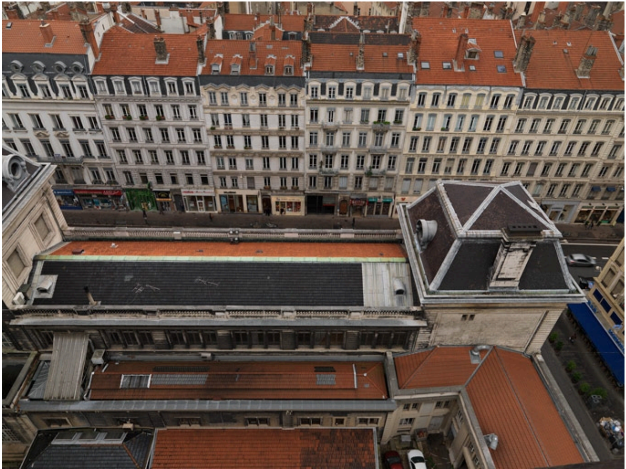
Le bâtiment A'. Vue d'ensemble depuis le nord
