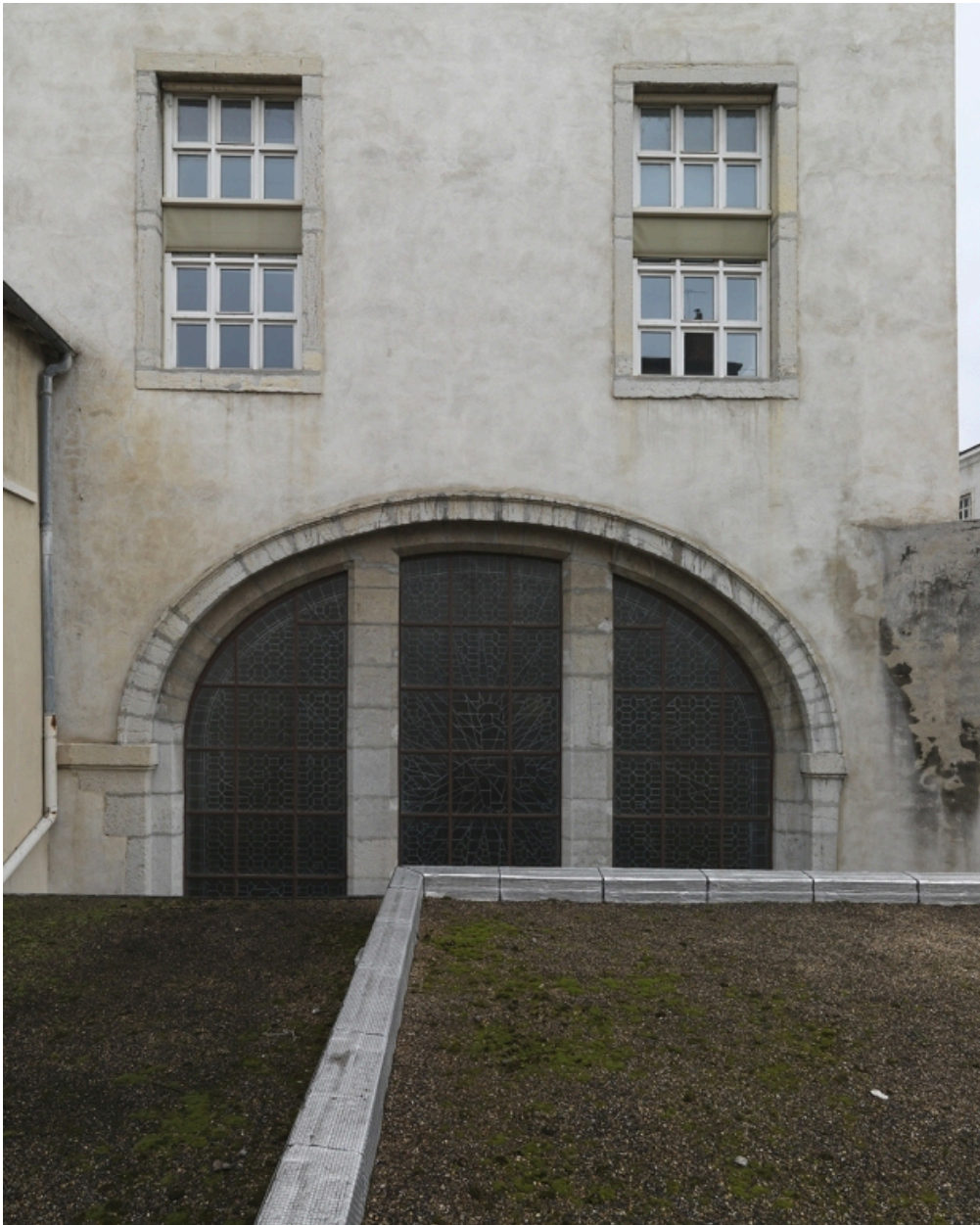
Bâtiment G. Façade ouest, les deux premiers niveaux
