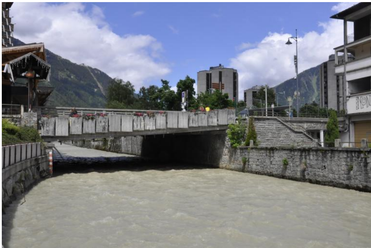
Vue de la face aval du pont
