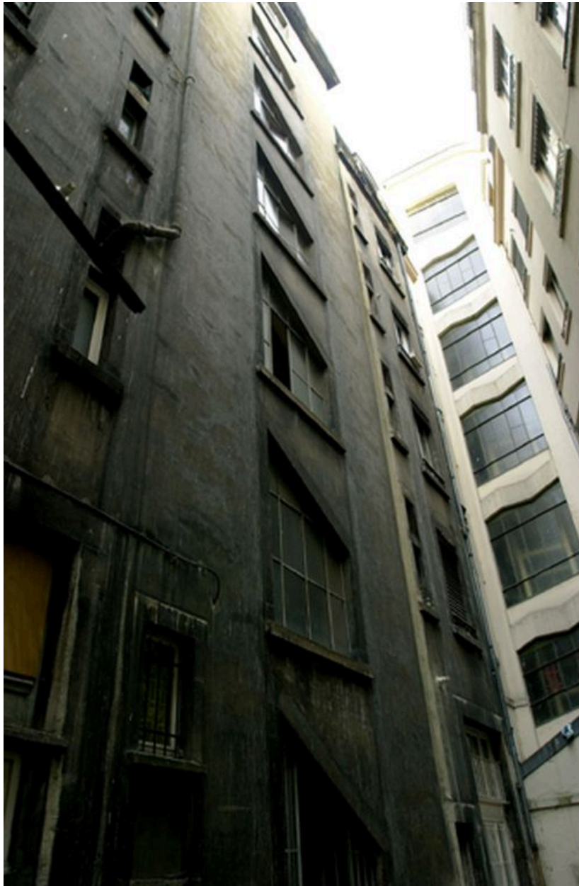
Elévation postérieure, la travée d'escalier
