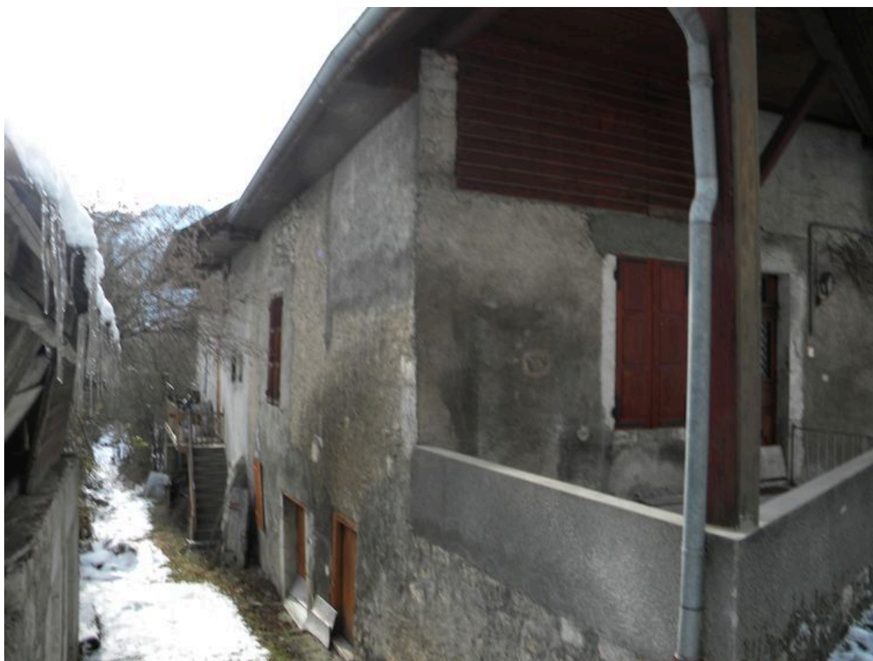
Façade principale et façade d'entrée des parties agricoles.
