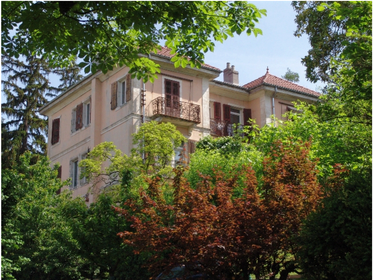
Vue prise du sud-ouest
