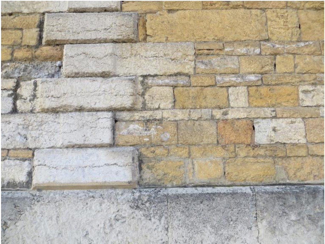
Etat au 19 février 2013 : mur d'enceinte quai Perrache : détail de matériaux
