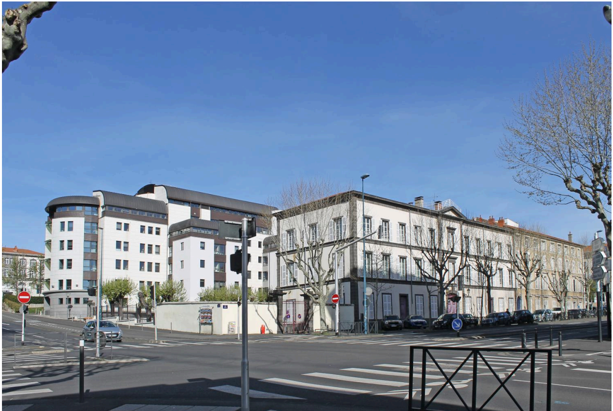
Clermont-Ferrand, angle nord-ouest du carrefour entre le cours Sablon et l'avenue Carnot, au voisinage de la succursale de la Banque de France.
