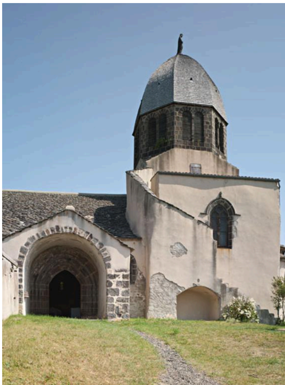
Vue de détail de la façade méridionale.
