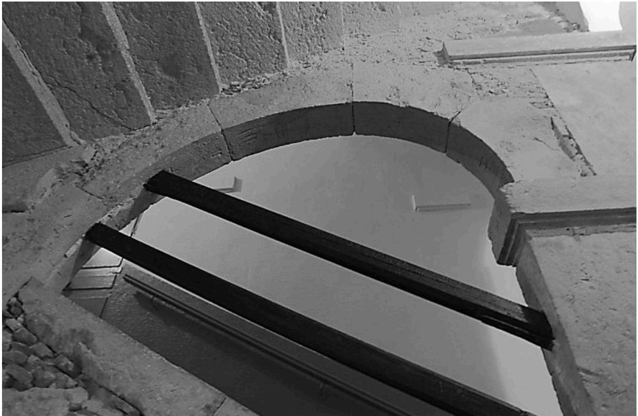
Escalier, ajouement du mur-noyau vu depuis le palier du rez-de-chaussée
