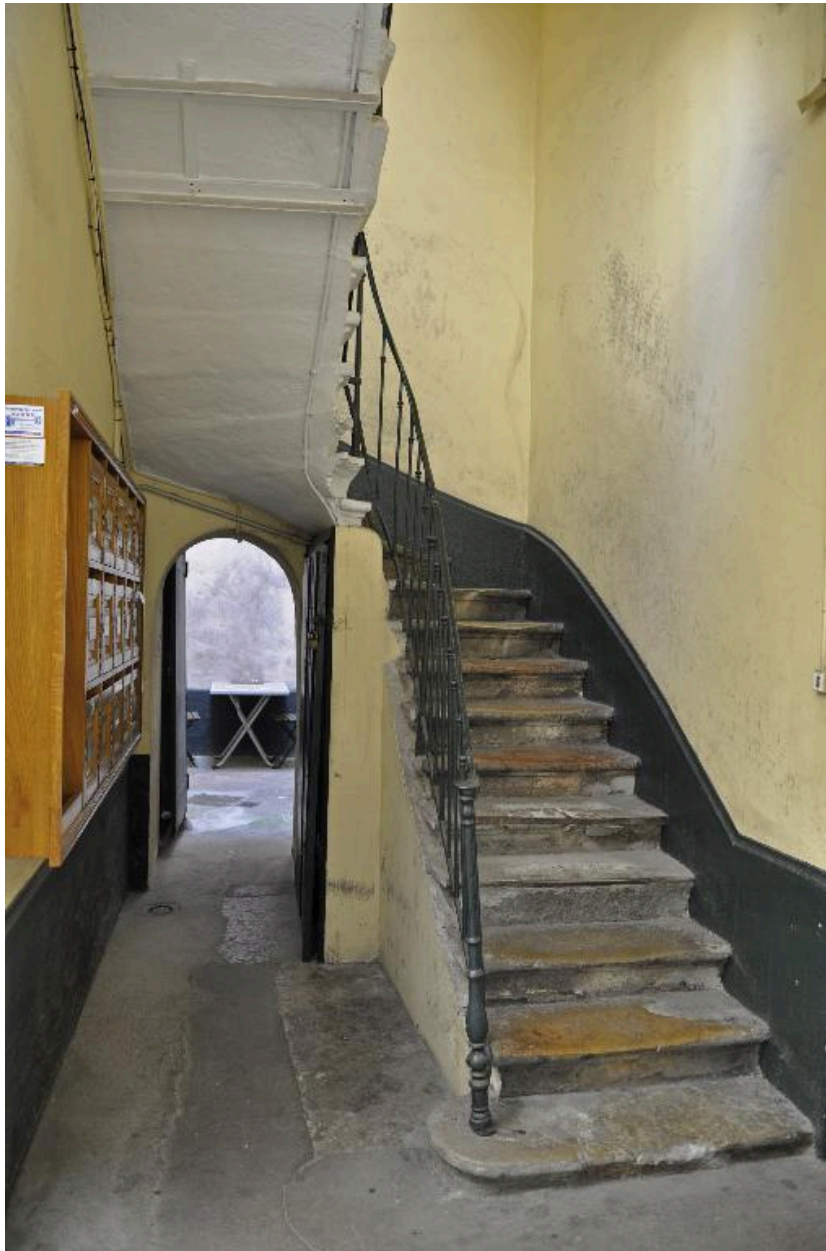
Cour, vue de l'escalier reliant les deux bâtiments
