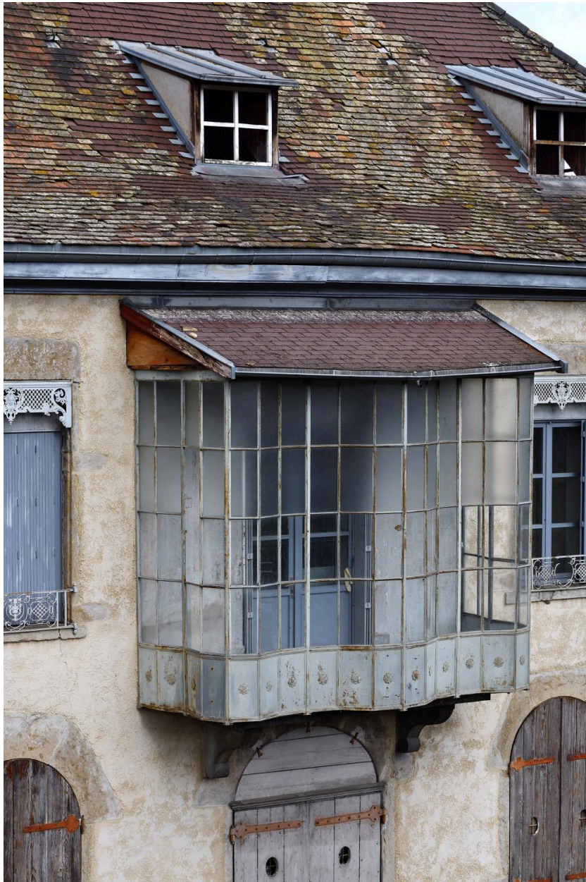
Détail galerie à l'étage
