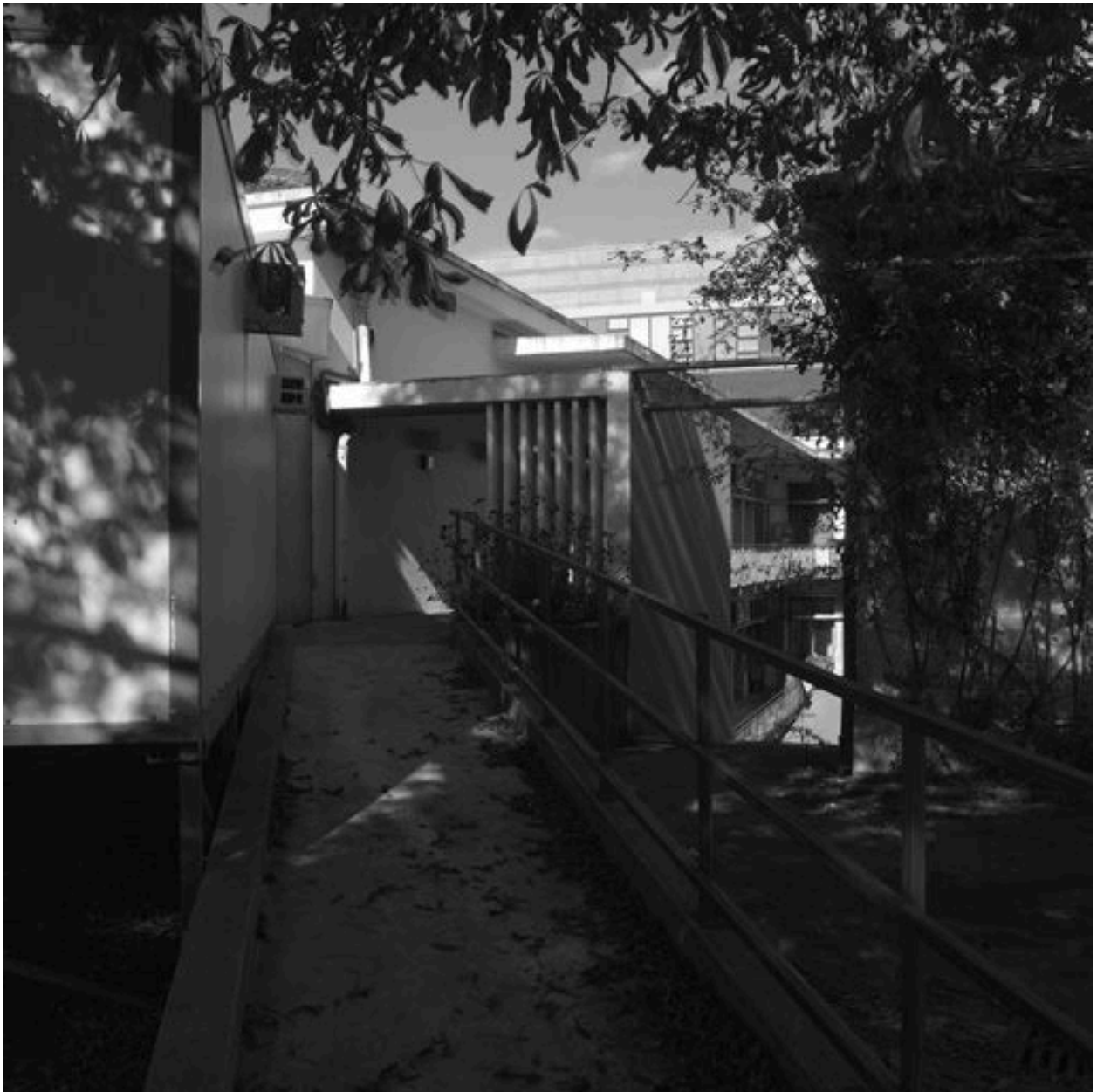
Bâtiment W, entrée des galeries est, à côté de la grande entrée au sud
