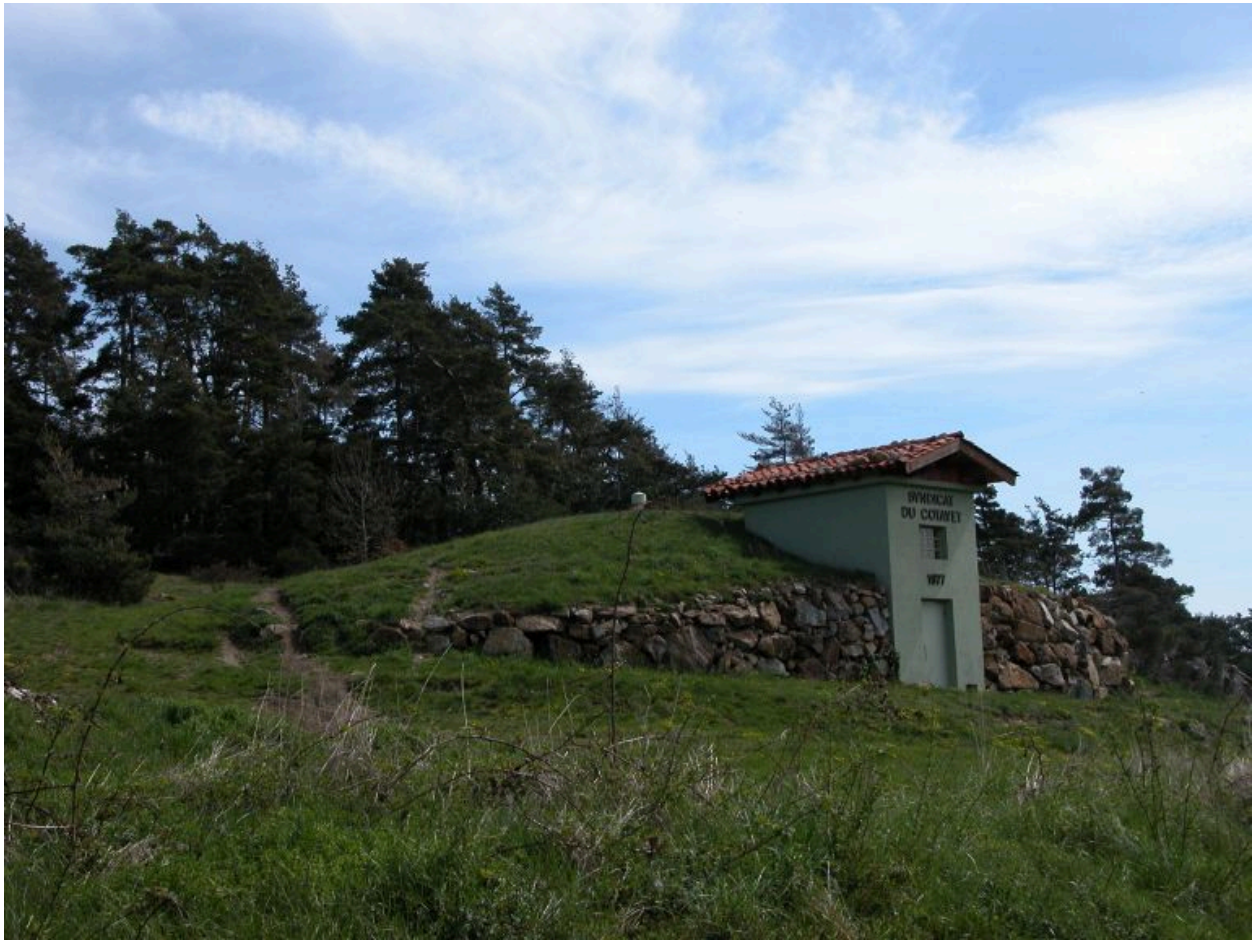
Pic (le), D 381. Vue d'ensemble du réservoir d'eau.
