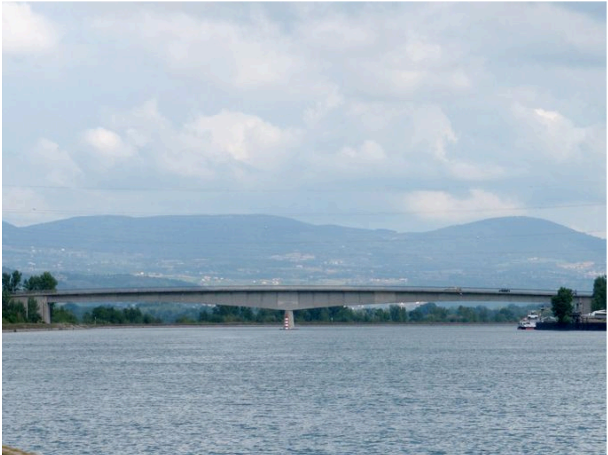
Vue générale, face aval (depuis l'usine de Sablons)
