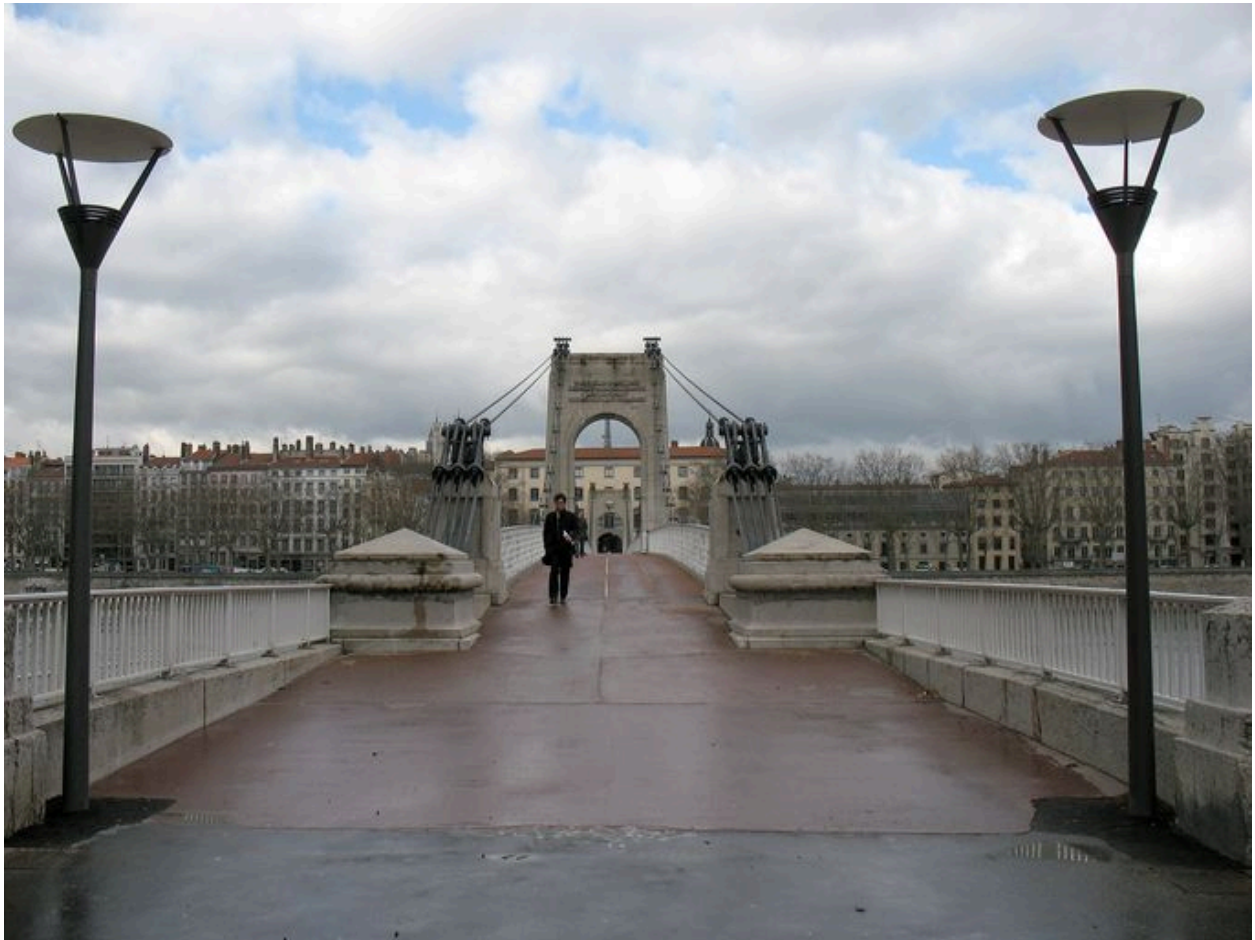
Vue de la chaussée (depuis la rive gauche)
