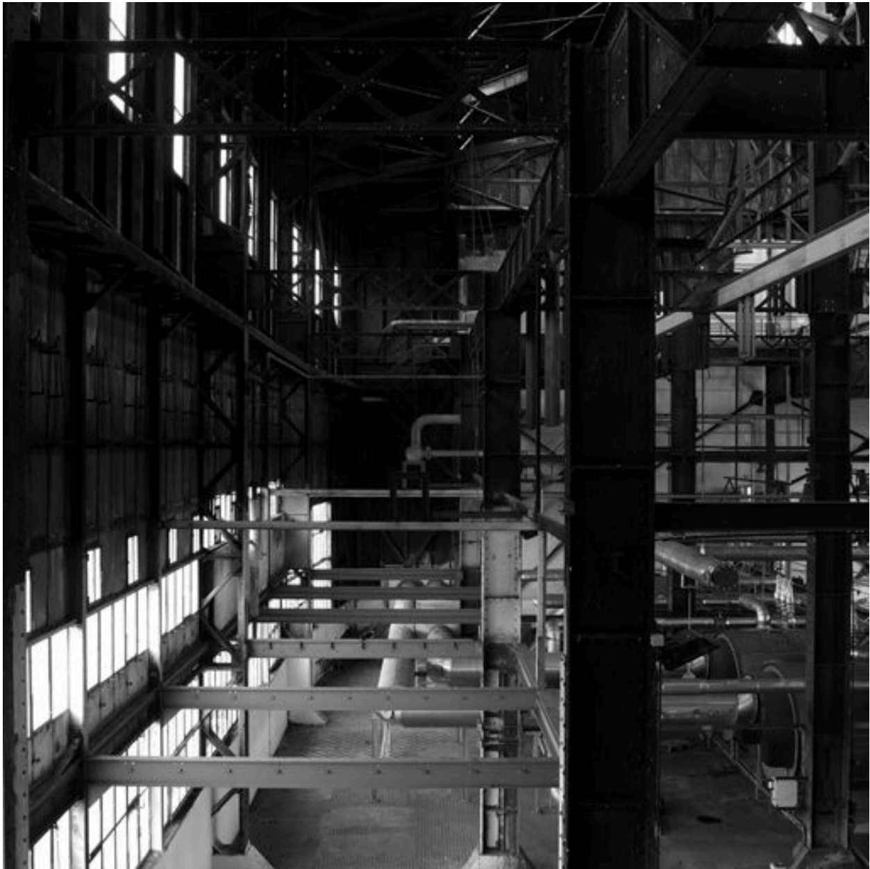
Vue d'ensemble de la superstructure métallique. La travée méridionale et l'ensemble des chaudières
