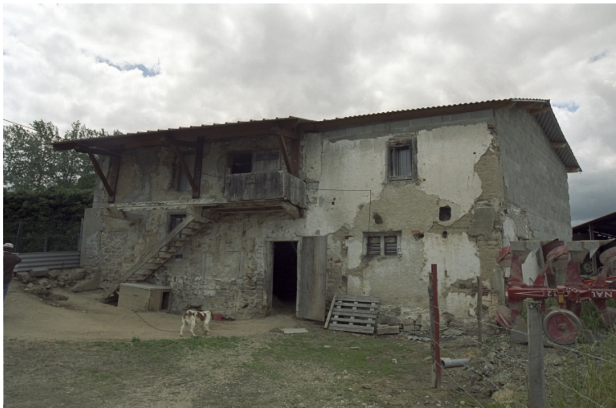
Bussy-Albieux, Domaine de la Croix-Blanche (1987 B1 576). Vue d'ensemble de l'ancien logis.
