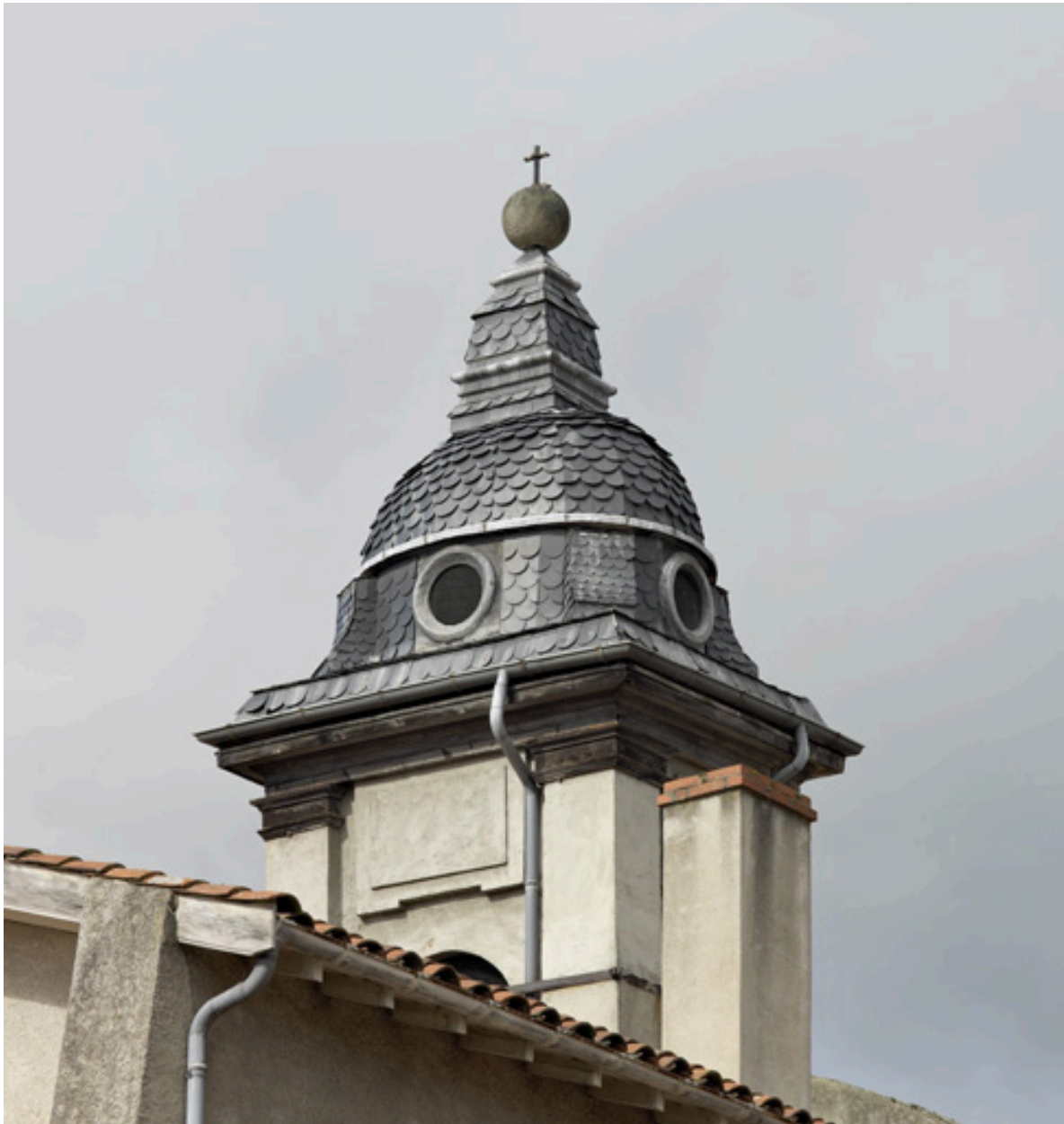
Détail du clocher, vue prise depuis le nord-est.
