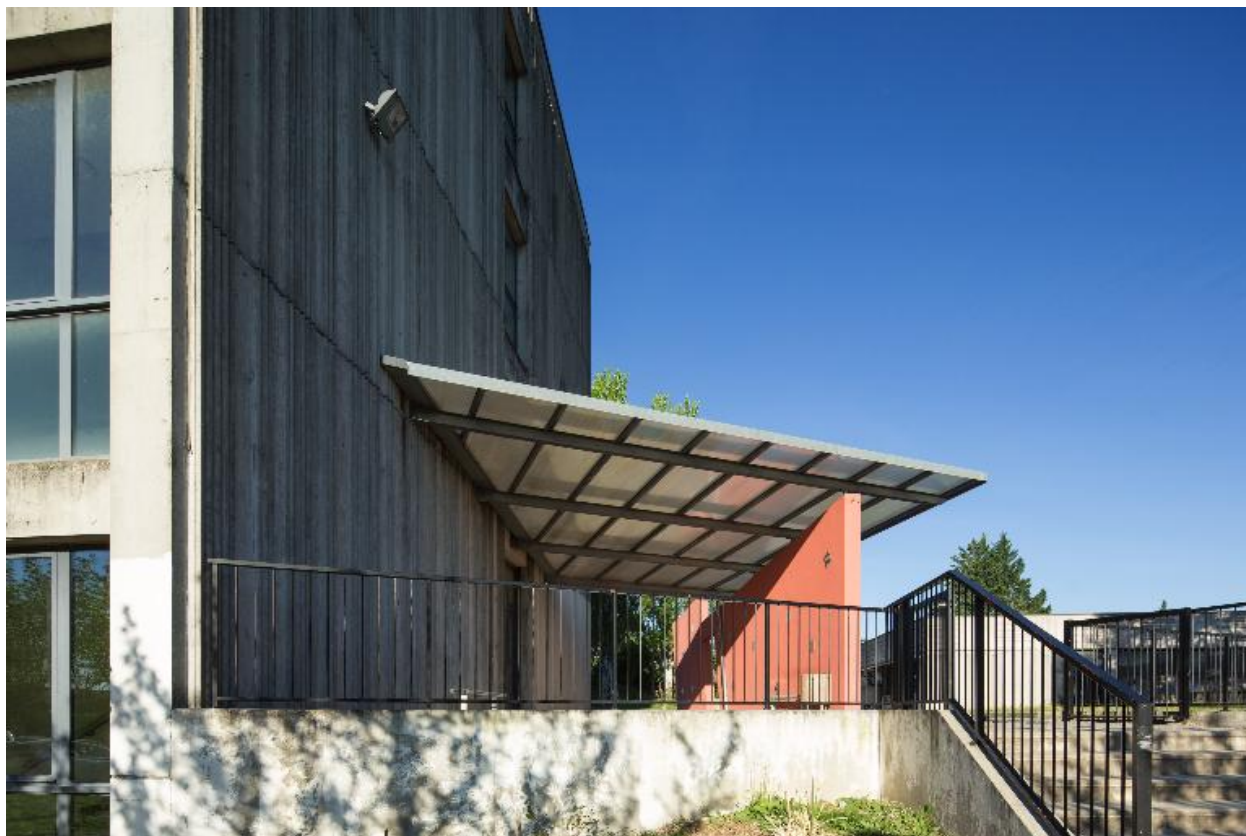
Bâtiment nord : pignon nord.
